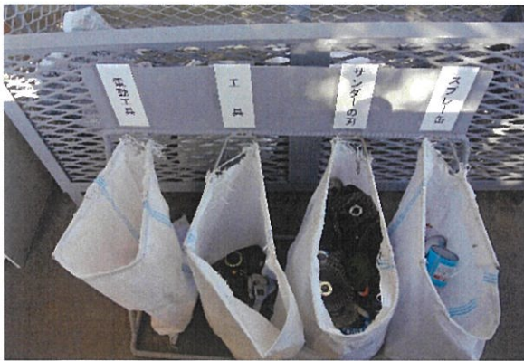
電動工具・工具・サンダーの刃・スプレー缶にそれぞれの土のう袋に分別
